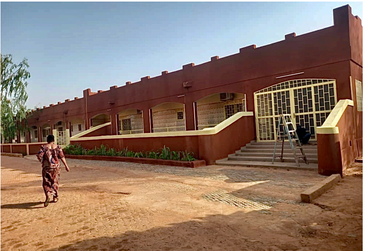
Extension de la maternité et entrée principale de l'auditoire
