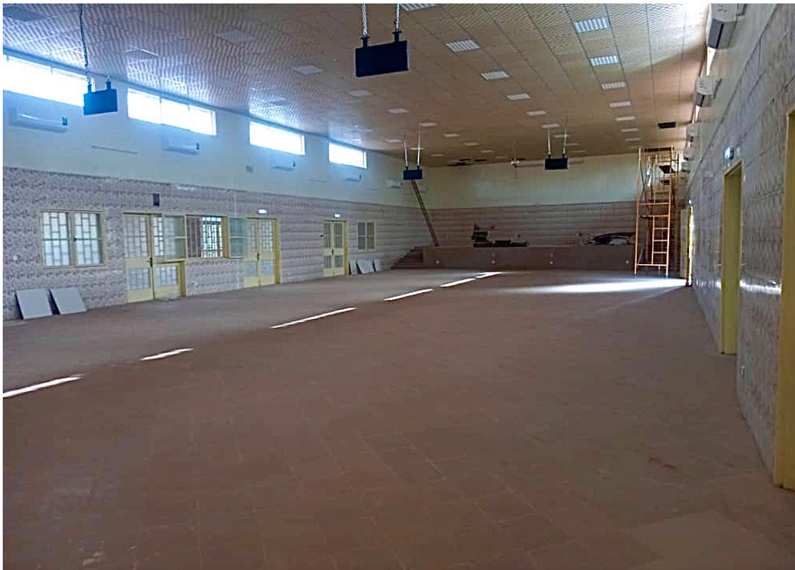
La fin des travaux de l'auditoire qui pourra accueillir 300 personnes
